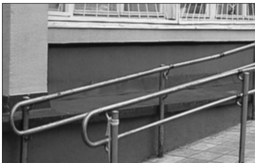
Фото 15. Пример исполнения двухуровневых перил пандуса
